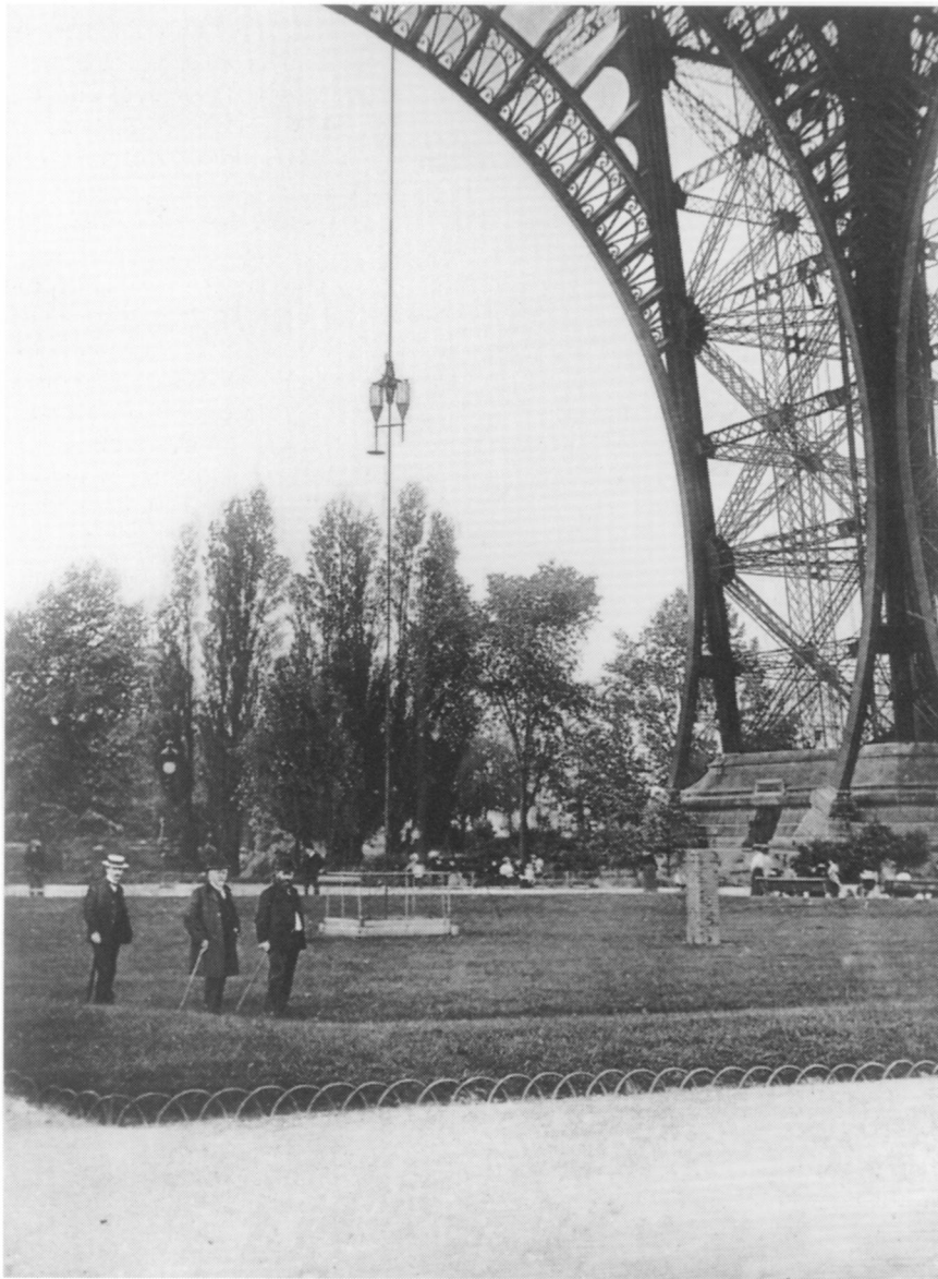
Fig. 17. Apparatus for measuring the air resistance of falling objects. (Reprinted from Gustave Eiffel, Recherches expérimentales sur la résistance de l'air exécutées à la Tour Eiffel [Paris, 1907] facing p. 12.)
