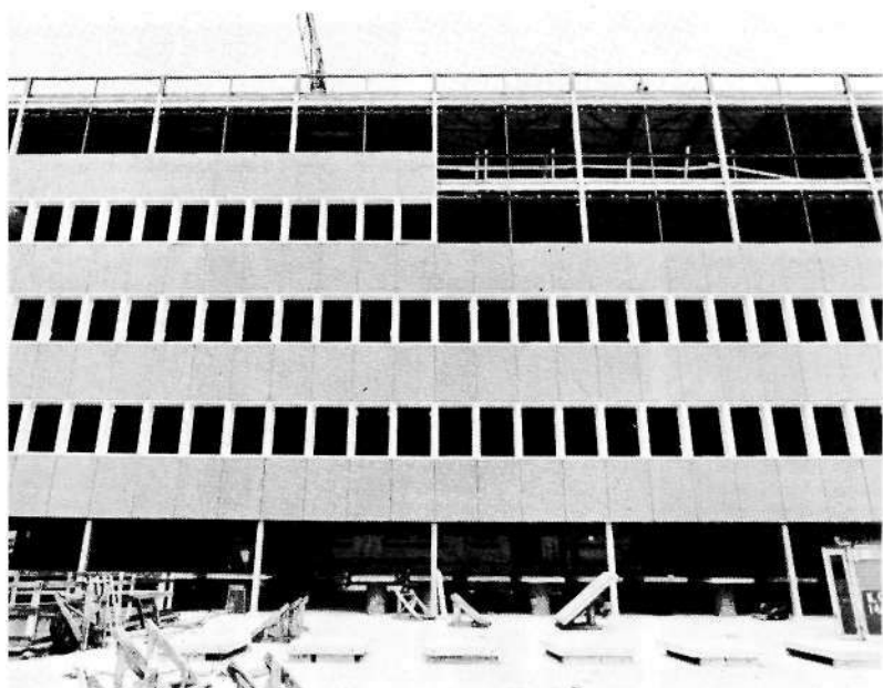
Vista de la colocación de los elementos prefabricados en la fachada
