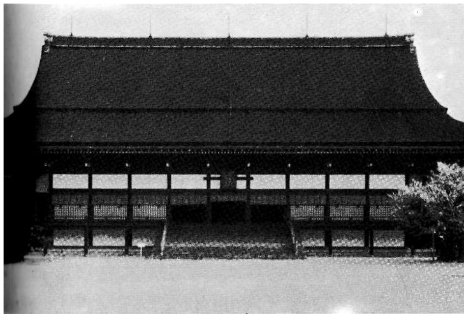
Composición exacta de módulos y submódulos en el antiguo Palacio Imperial de Kyoto, construido en madera, paja y papel
