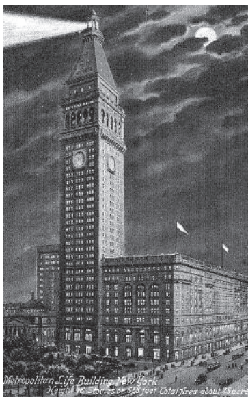
Edificio Metropolitan Life, concebido en dos operaciones separadas: el bloque principal de 10 pisos, en 1893; la torre metropolitana, en 1909 (arquitectos: Napoleon LeBrun e hijos).
