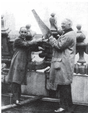
“Los señores Raskob y Smith empiezan a demoler el Waldorf”.
