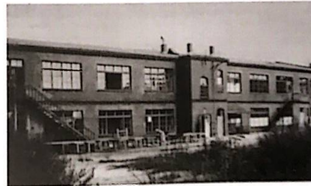
L'edificio che il Bauhaus occupò a Berlino-Steglitz sulla Birkbuschstraße era una vecchia fabbrica di telefoni da tempo abbandonata. Foto di Hansard Deaton, fine 1932.
